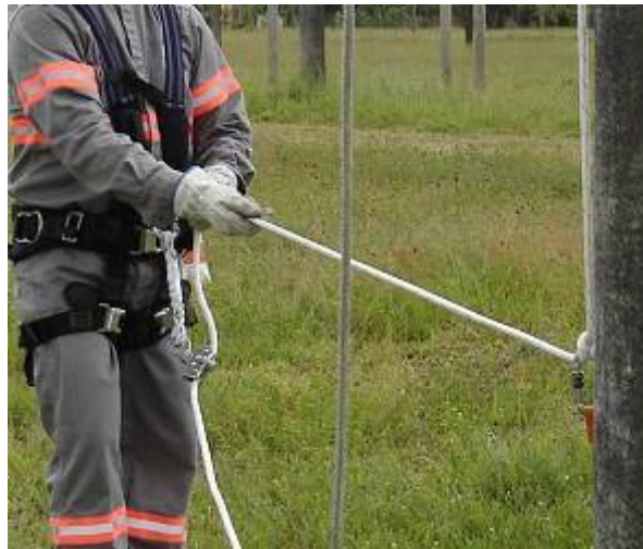
Figura 40 – Acionamento do nó de freio
