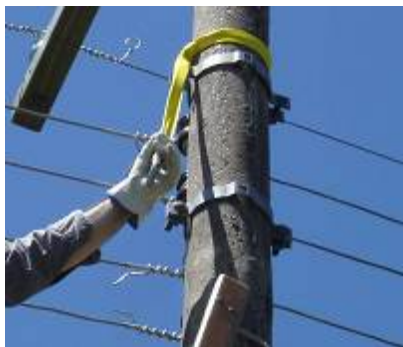
Figura 16 – Ancoragem com fita e mosquetão no poste
