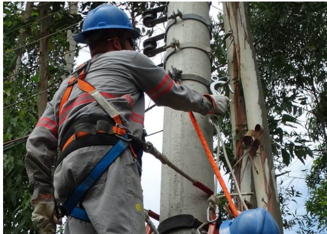
Figura 48 – Fixação do ponto de ancoragem
