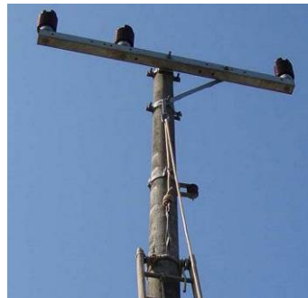
Figura 17 – Ancoragem na ferragem do poste
