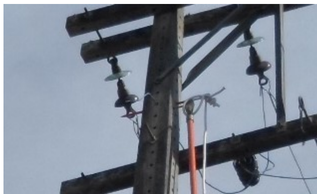
Figura 31 – Instalação do agulhão no poste
