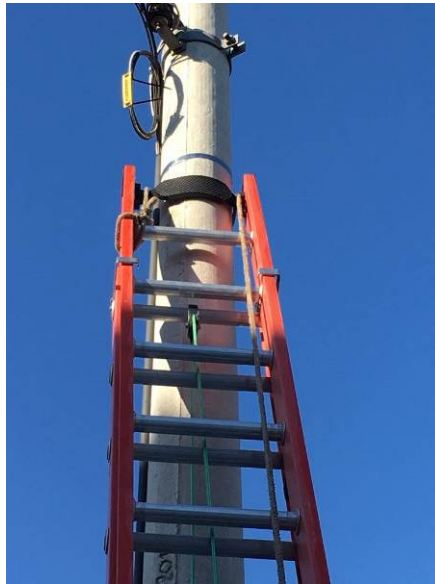
Figura 23 – Posicionamento da escada
