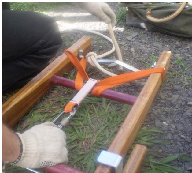
Figura 12 – Instalação do ponto de ancoragem
