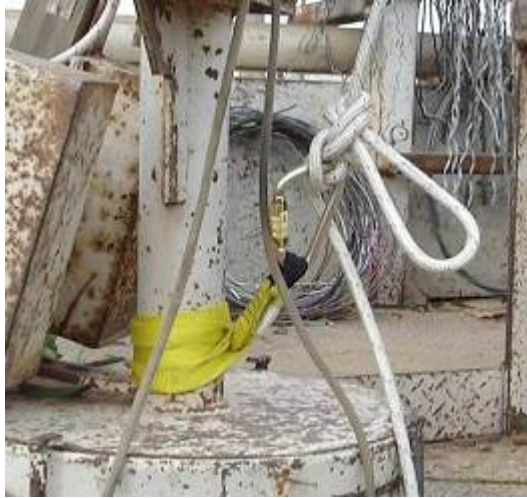
Figura 11 – Ponto de ancoragem
