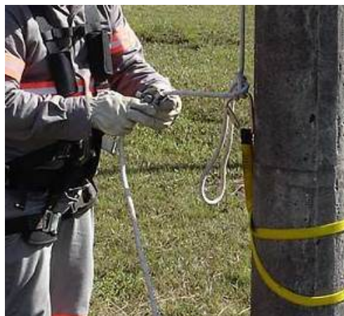
Figura 39 – Instalação do trava-quedas
