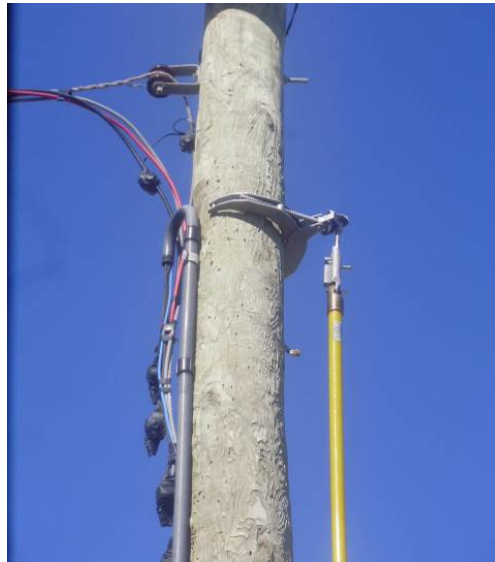
Figura 27 – Ancoragem da garra
