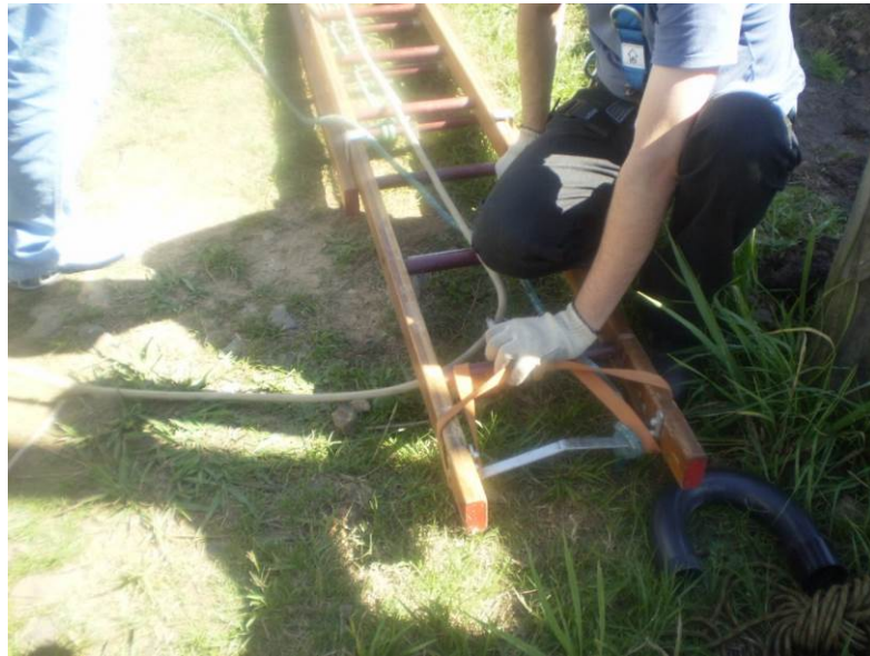
Figura 13 – Instalação da linha de vida
