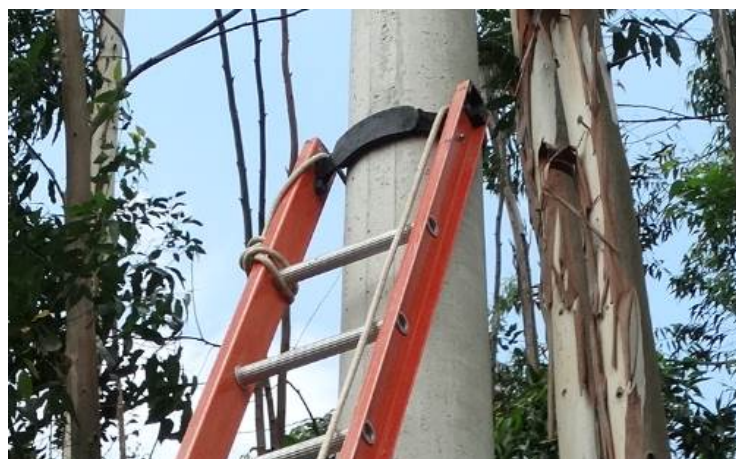
Figura 22 – Posicionamento da escada
