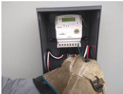
Figura 3 – Retirada do condutor de saída
